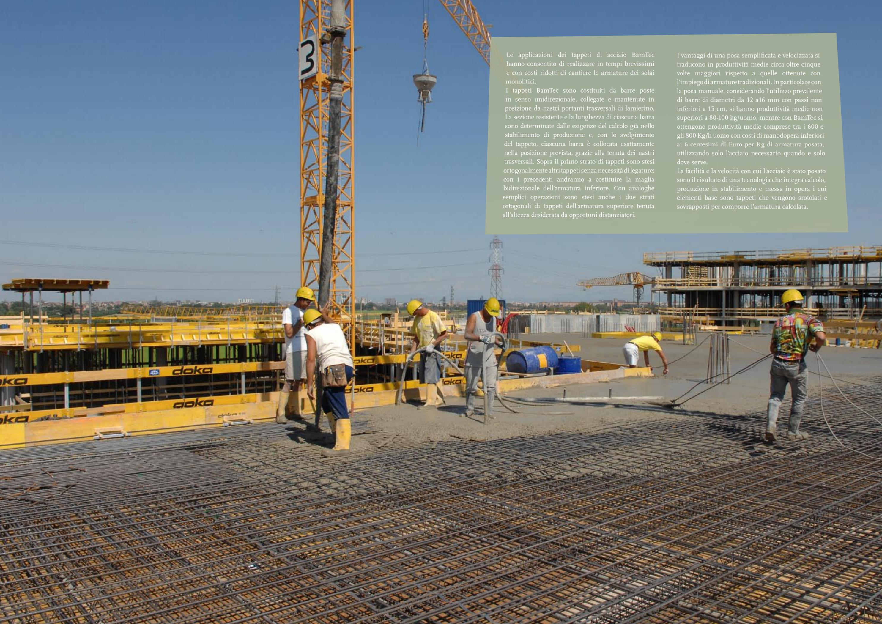
Le applicazioni dei tappeti di acciaio BamTec hanno consentito di realizzare in tempi brevissimi e con costi ridotti di cantiere le armature dei solai monolitici.
