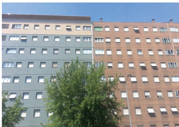
Prospetto dell'edificio prima e dopo l'intervento di riqualificazione. La facciata è stata rivestita con isolamento termico a cappotto e clinker
