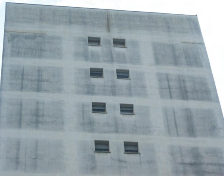
Formazione di patina biologica "muffe" e ammaloramento dell'intonaco per presenza di umidità diffusa su ampie superfici delle pareti perimetrali. Isolamento termico inadeguato
